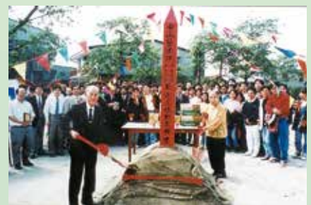
1995 年，口腔大樓動工
